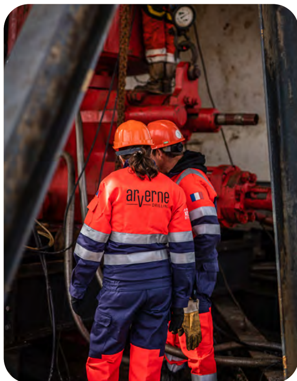
Forage de géothermie profonde
