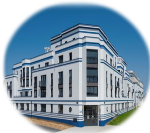
Résidence Le Métropolis – Chessy (77) – 50 logements
